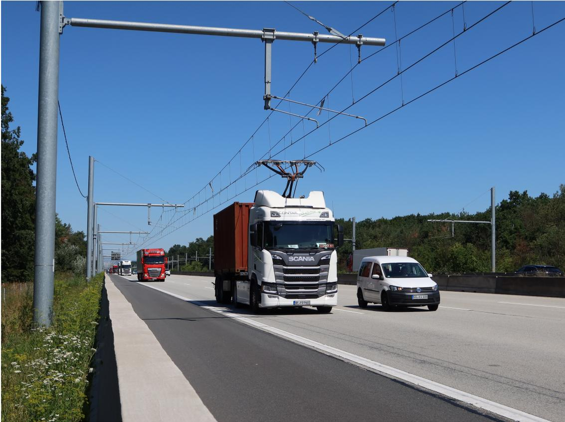
Abbildung 6: Oberleitungsanlage entlang einer Autobahn (Quelle: TU Dresden – Professur für Elektrische Bahnen)
