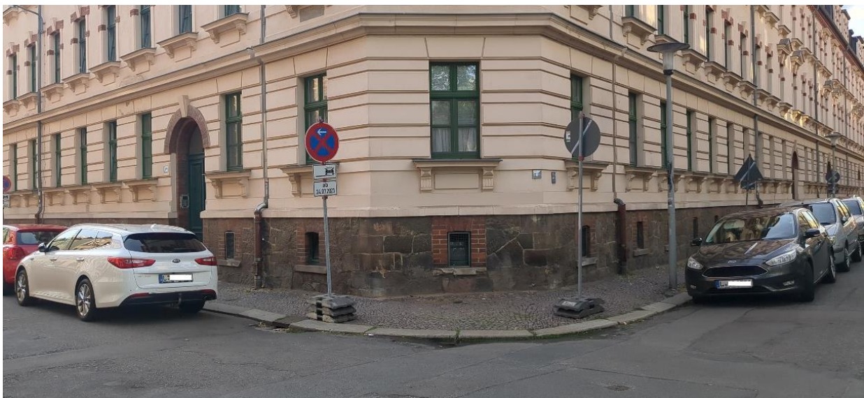
Abbildung 32: unebene Pflasterung und nicht abgesenkte Bordsteine (Quelle: eigene Aufnahme)
